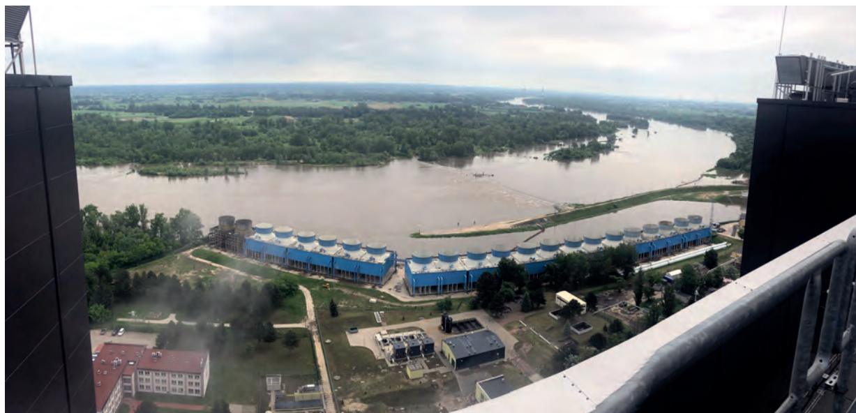
Fot. 2. Widok na Wisłę z dachu bloku 1075 MW
