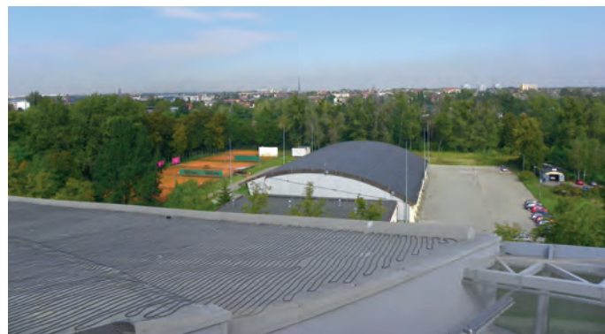
Fot. 3. Widok z dachu Hali Gliwice
