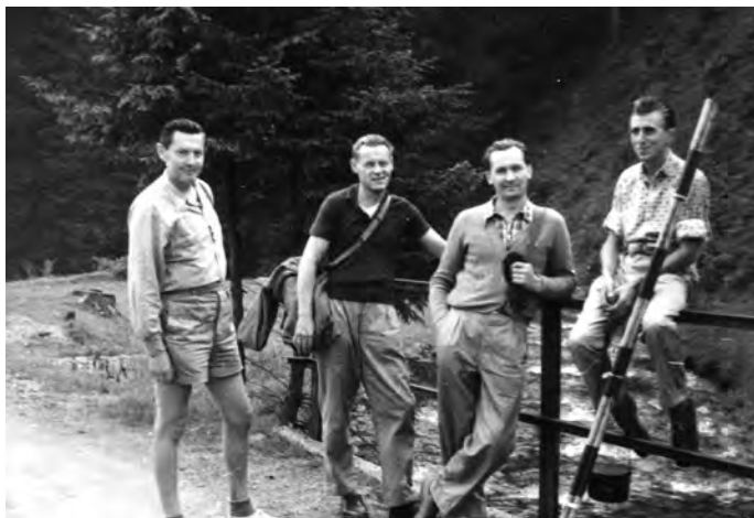
Fot. 5. Trasowanie linii wysokiego napięcia, 1985 r.
