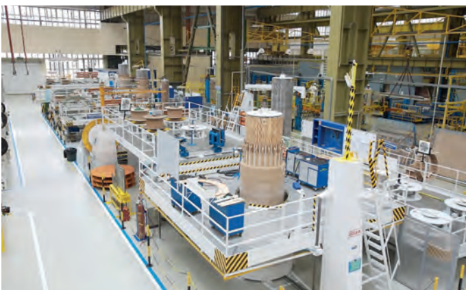
Fot. 4. Widok na halę produkcji transformatorów (zdj.: www.new.abb.com)
