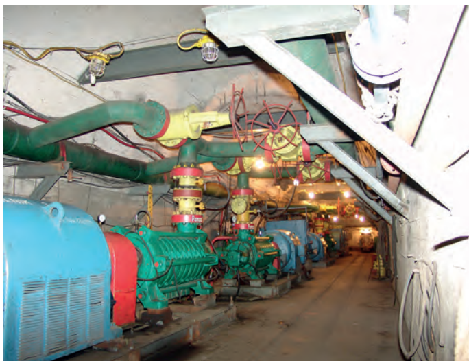
Fot. 5. Pompownia w kopalni Kleofas
