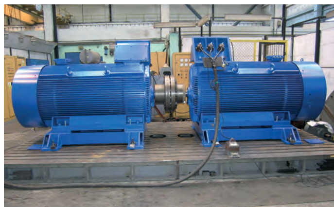
Fot. 1. Próba obciążeniowa na płycie silników o mocy 1 MW o napięciu zasilania 6 kV
