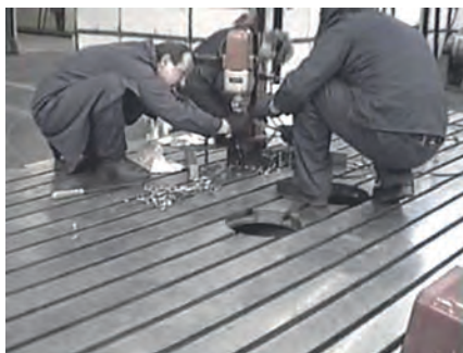
Fot. 3. Prace związane z modernizacją stanowiska
